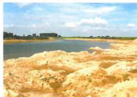
Aanleg van een nevengeul in de Klompenwaard
